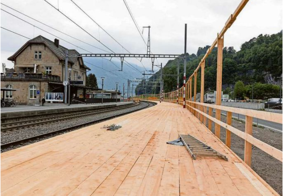
Der Bahnhof Näfels-Mollis wird ausgebaut: Hier entsteht ein zusätzliches Perron aus Holz.
