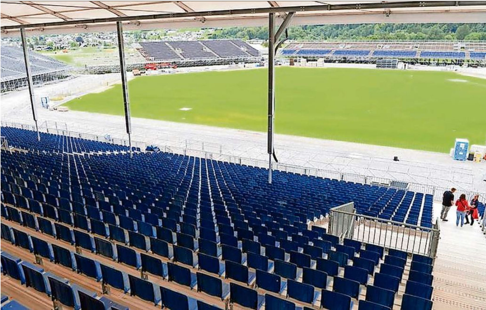
Bald ist es so weit: Die Bauarbeiten an der Esaf-Arena laufen auf Hochtouren.
