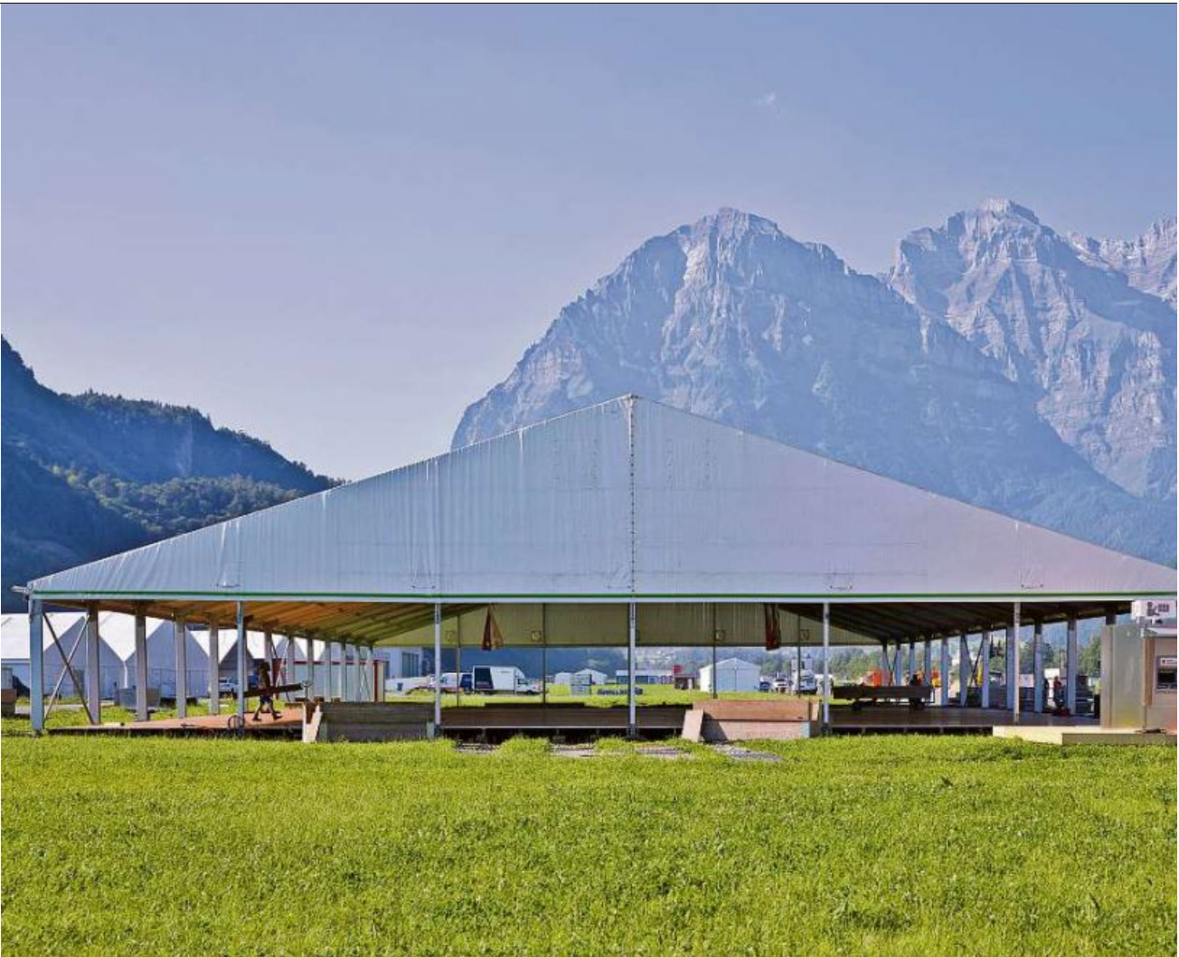
Hier wird Party gemacht: Zehn Festzelte werden auf dem Esafgelände aufgebaut.
